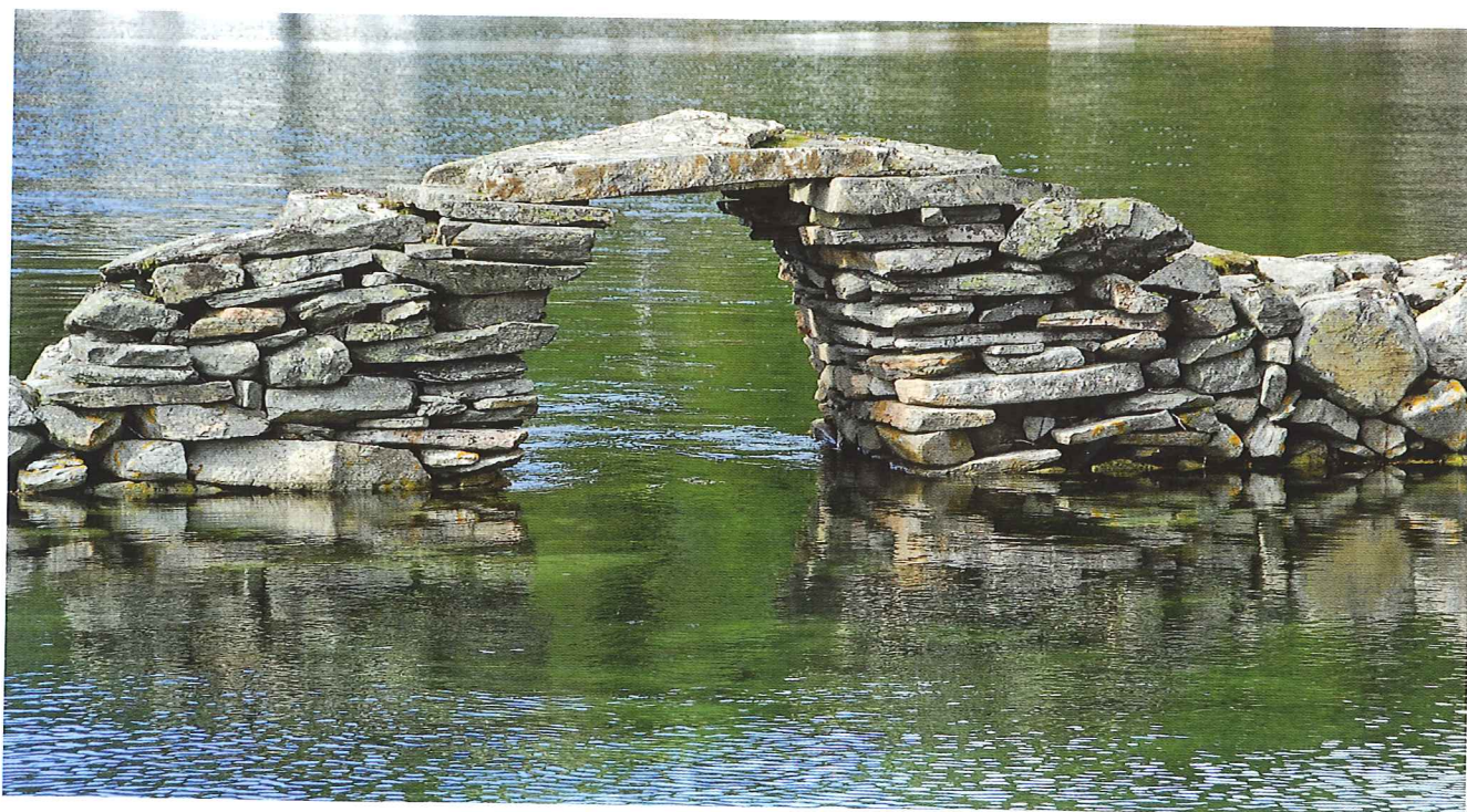
Skifriheten gjør at berget sprekker opp langs en bestemt retning, noe som gjør den anvendelig til både murer og små brokonstruksjoner, som her ved Lygra.
